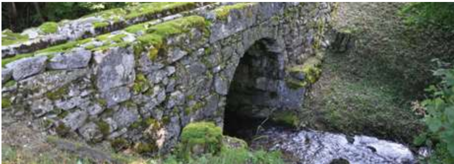
Das Viadukt über den Boninger Bach bei der Aare war Teil eines Bewässerungssystems.
