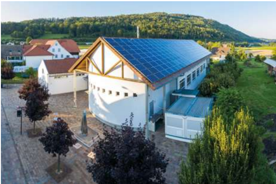
Im Schultrakt der Schnäggehalle findet der Unterricht der Primarschule statt.
