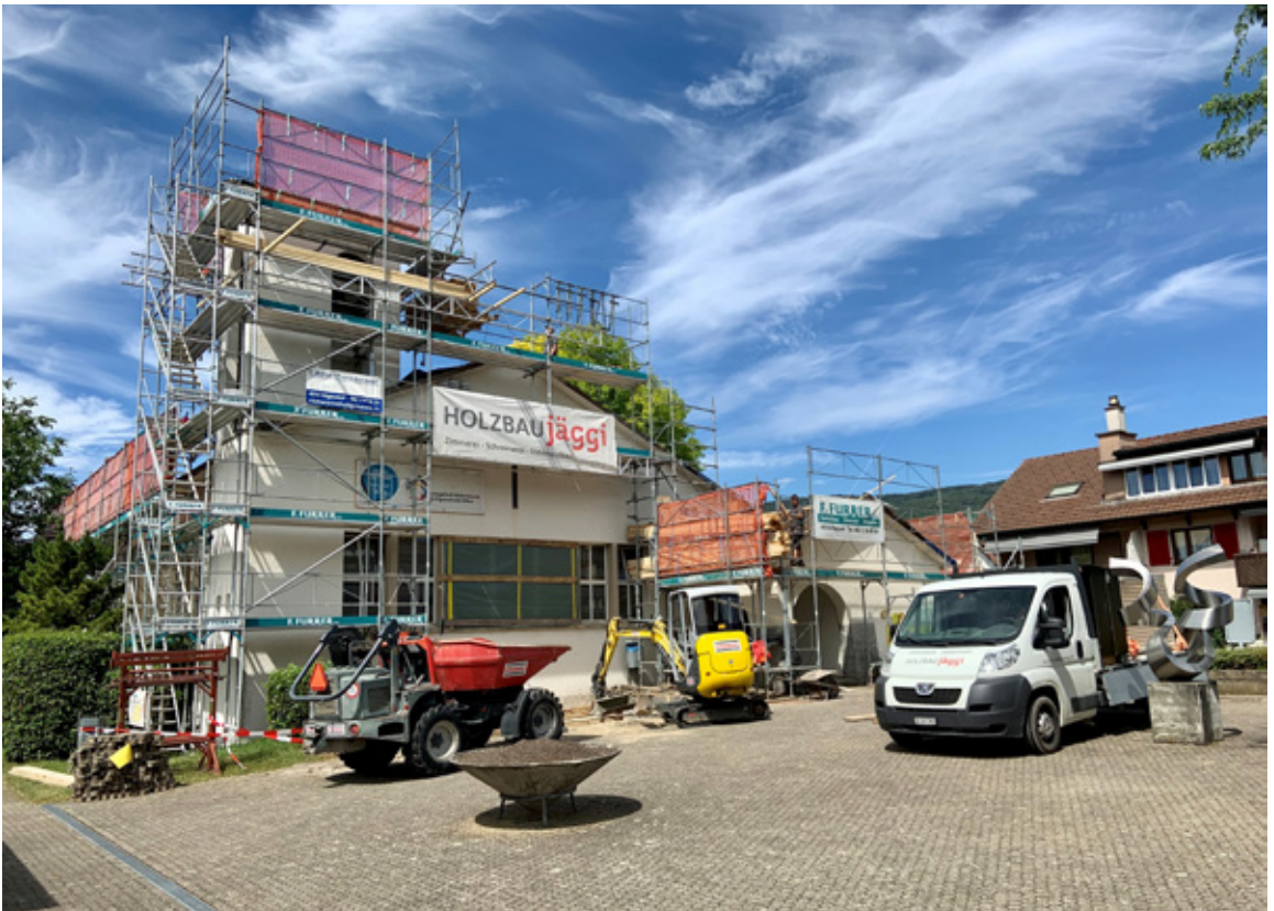
Bauarbeiten in vollem Gange.
