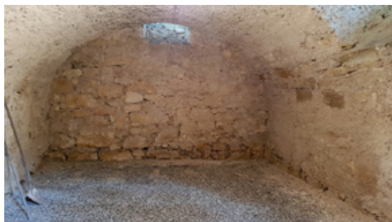
Der Keller vor dem Umbau...
