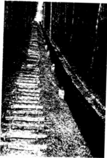
Die ehemalige Treppe und Rohrleitung der Pumpspeicheranlage Ruppoldingen-Born
