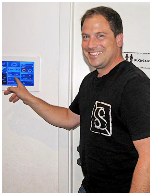
Über das Tablet im Flur kann Kay von Büren die elektronischen Geräte im Haus steuern.
