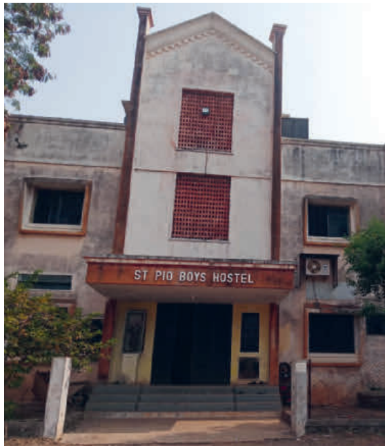
Das Kinderheim Osnamabad vor der dringend nötigen Renovation...
